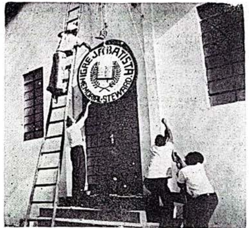
A placa para o Templo Batista Memorial Steward, em Tanquinho, sendo colocada no seu lugar. Na escada, o irmão Otacilio de Jesus Conceição, pedreiro. Segurando a placa, o missionário Mack Shults. Puxando a corda que levanta a placa: os irmãos Givaldo Vieira, Vitor Ribeiro de Freitas e Antônio Lisboa dos Santos. 19-6-68 (Foto de Roberto Hampton).
