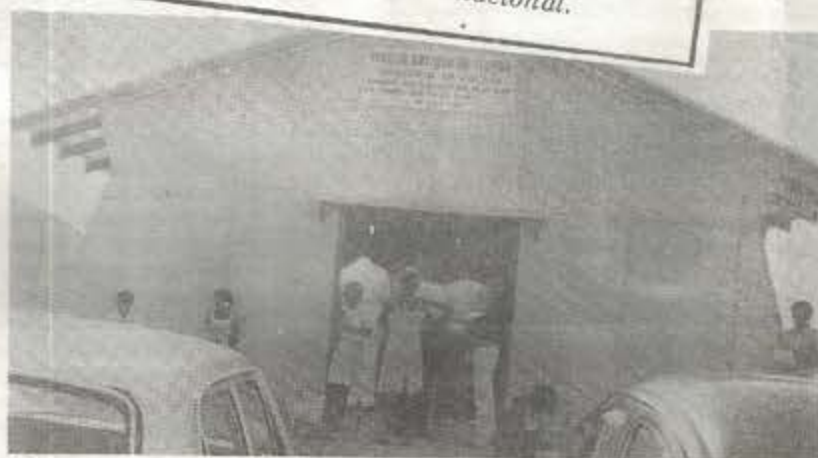
IGREJA BATISTA DE ITAPOÁ — primeira capela pré-fabricada, construída em Salvador. Artigo na pág. 04.
