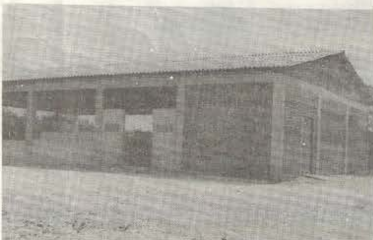
O galpão do Acampamento.
