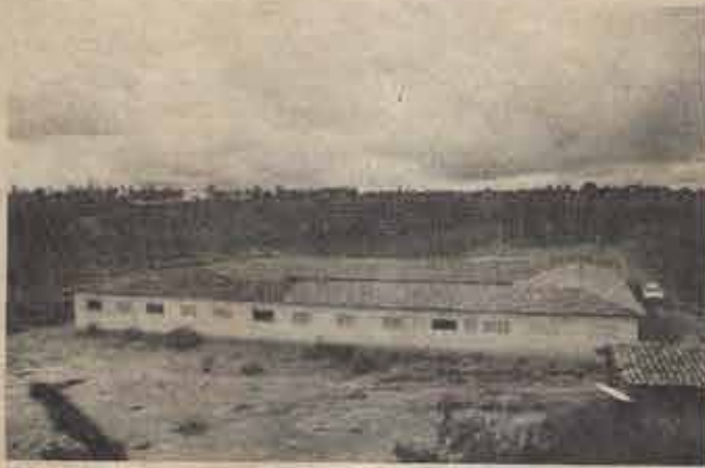
Colégio onde funciona o Centro Batista de Esplanada
