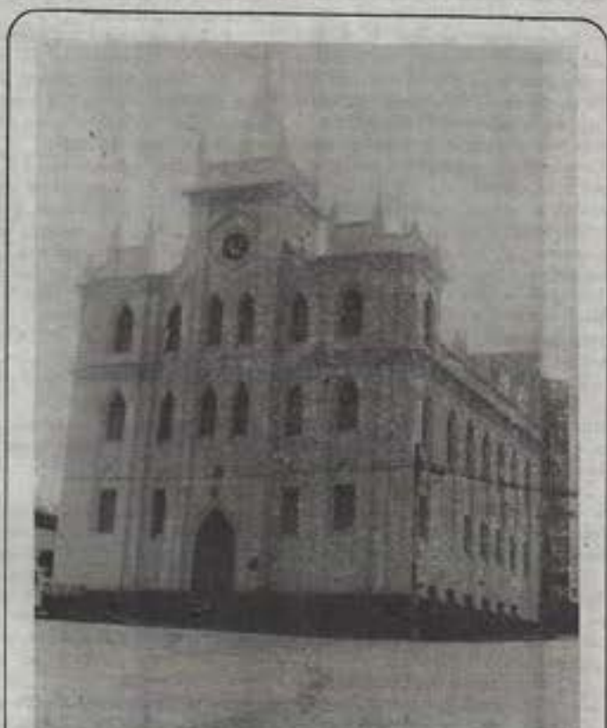
1º IB — Itapetinga, recebe reforma no seu santuário e inaugura o seu edifício de Educação Religiosa (Na data 12-16 de julho ela receberá a 62ª Assembléia da Convenção Batista Baiana)
